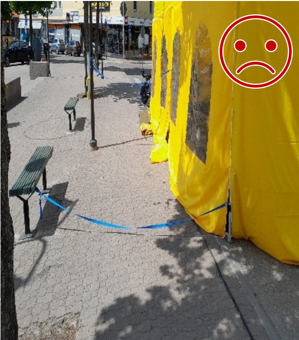
Bild 12 INTE SÅ HÄR. Vågrät fastsättning hindrar inte tältet från att stiga upp i luften. Linan medför dessutom risk för snubbling.
